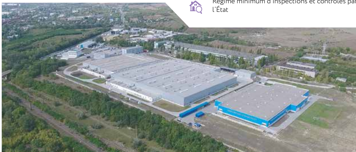
Crédit photo : Invest in Moldova. Zone Franche de Balti, Sous-zone 2
